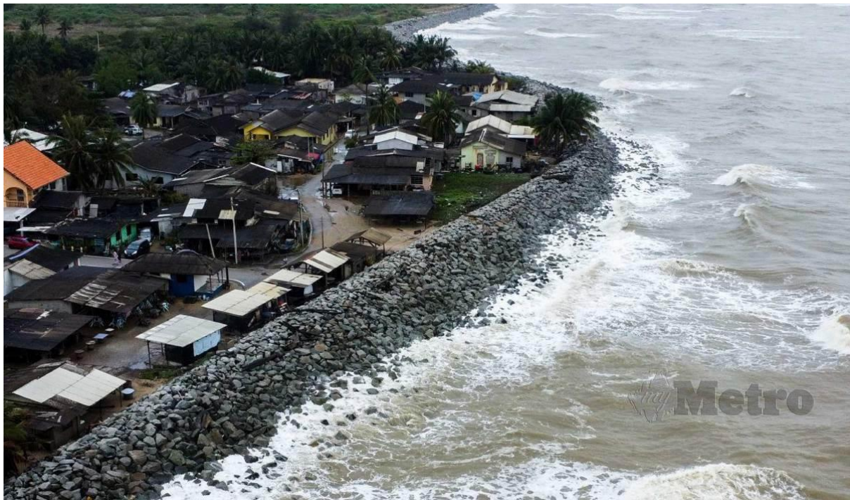
PEMBINAAN benteng pemecah ombak dapat mengurangkan asakan ombak yang membadai pantai hingga mengalami hakisan teruk. FOTO Nik Abdullah Nik Omar
